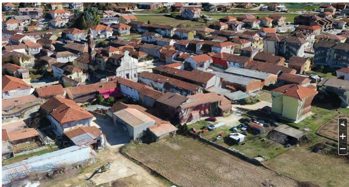
Figura 2: Esempio di elaborazione fotogrammetrica 3D dei dati rilevati con drone
