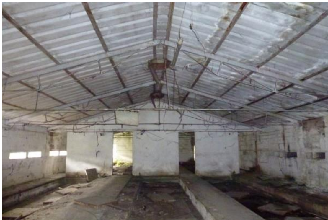
Figura 2 - Sito produttivo con coperture da bonificare.
