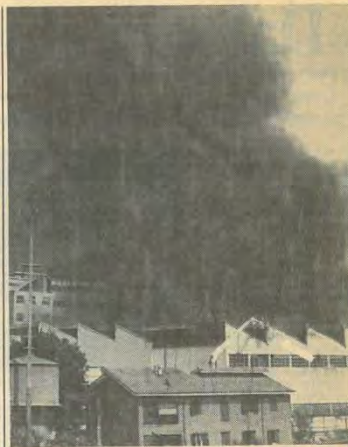
Una colonna di fumo nero si è alzata per ore dal palazzo di piazzale Lugano (Foto Corsera)
