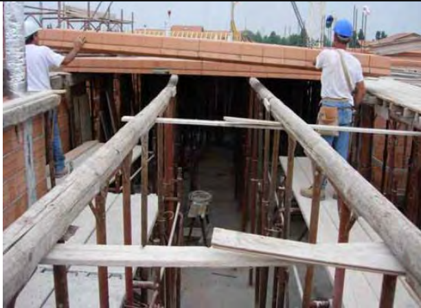
Posa di un solaio dal basso
