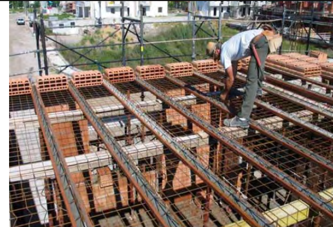
Utilizzo di reti elettrosaldate sopra le opere di banchinaggio
