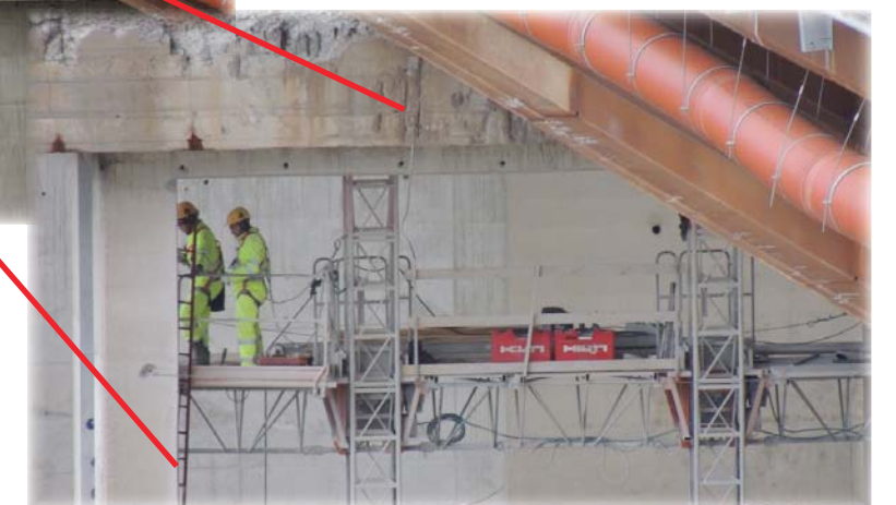
Forometrie in testa pila per la riduzione d'altezza necessaria ad eliminare il rischio d'interferenza della pila con il sovrastante nuovo impalcato, in fase di rotazione per il ribaltamento. Tagli a diamante e perforazione a secco con martelli elettrici a rotopercussione.
