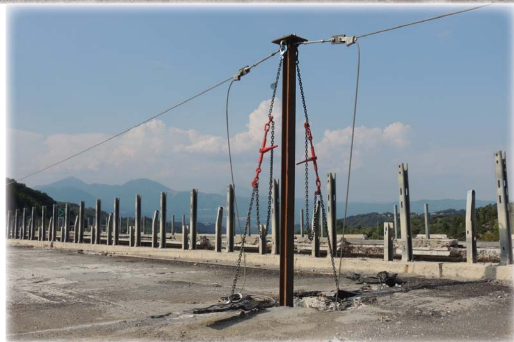
Dettaglio della linea anticaduta vincolata alle pile.
