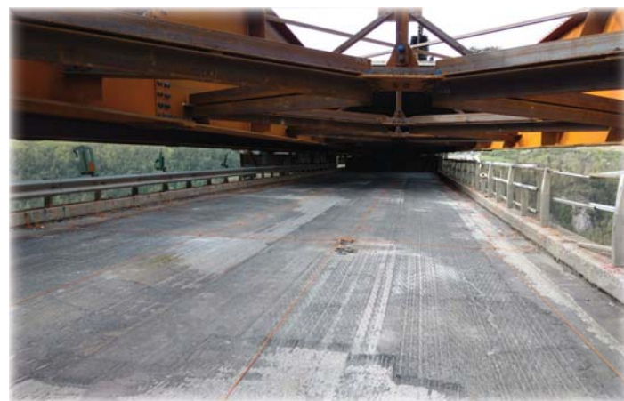
Nuova sovrastruttura del viadotto Jannello con la vecchia parzialmente demolita.
