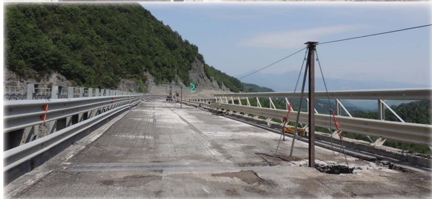
Dettaglio della linea anticaduta vincolata alle pile.
