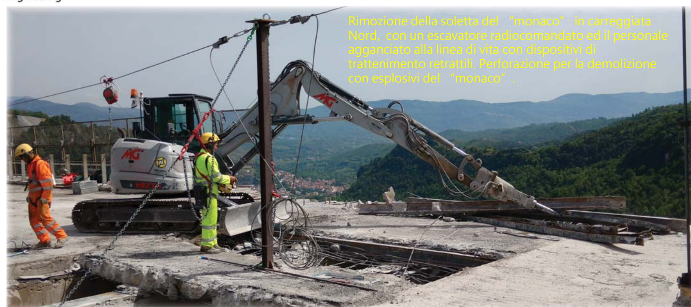
Demolizione della soletta tra le travi con escavatore radiocomandato, e perforazione dei fori da mina con carro di perforazione radiocomandato.
