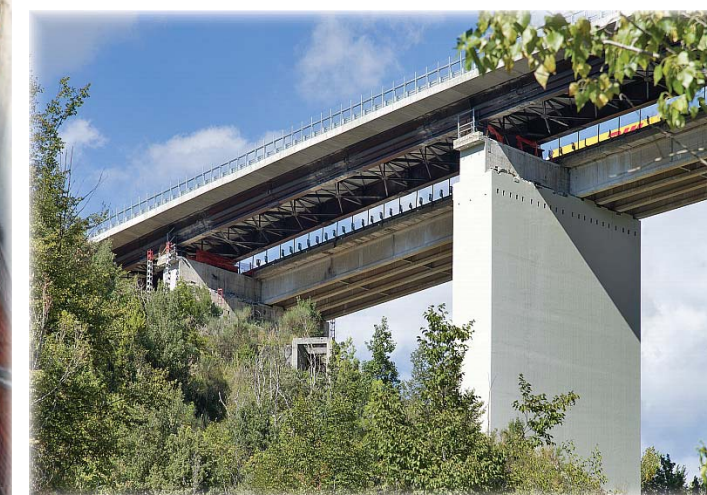
Dopo la demolizione della vecchia carreggiata SUD
