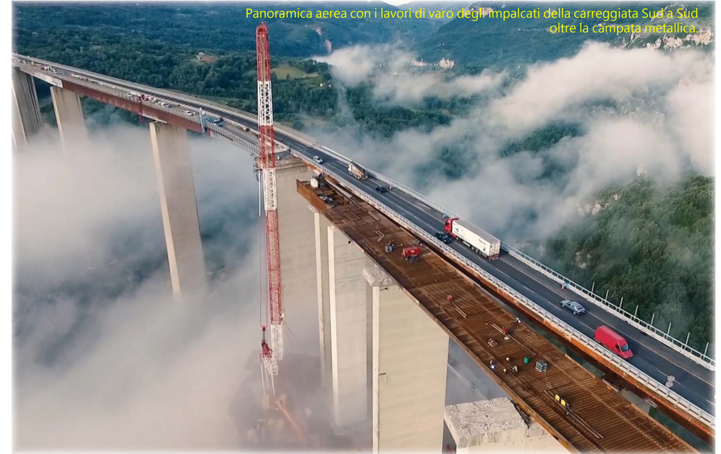
Lavori di adeguamento dei pulvini sulle pile per il varo degli impalcati della nuova carreggiata Nord.
