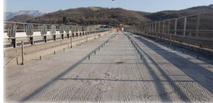
La carreggiata Sud a lavori di predisposizione per l'abbattimento completati. I coni verdi sono inseriti nei fori da mina. Tra i fori da mina la soletta tagliata a disco diamantato.
