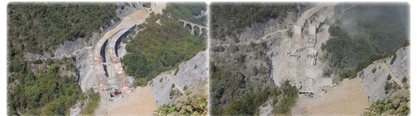
Il relitto del ponte a terra.
