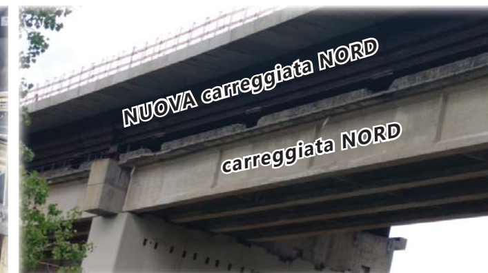
Il telaio in acciaio Corten della nuova sovrastruttura, appoggiata al vecchio piano di via già predisposto per l'abbattimento.
