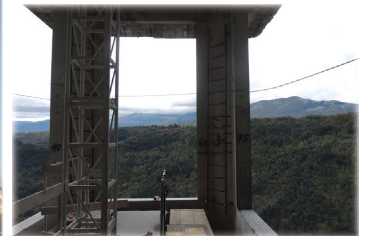
Forometrie in testa pila per la riduzione d'altezza necessaria ad eliminare il rischio d'interferenza della pila con il sovrastante nuovo impalcato, in fase di rotazione per il ribaltamento. Tagli a diamante e perforazione a secco con martelli elettrici a rotopercussione.
