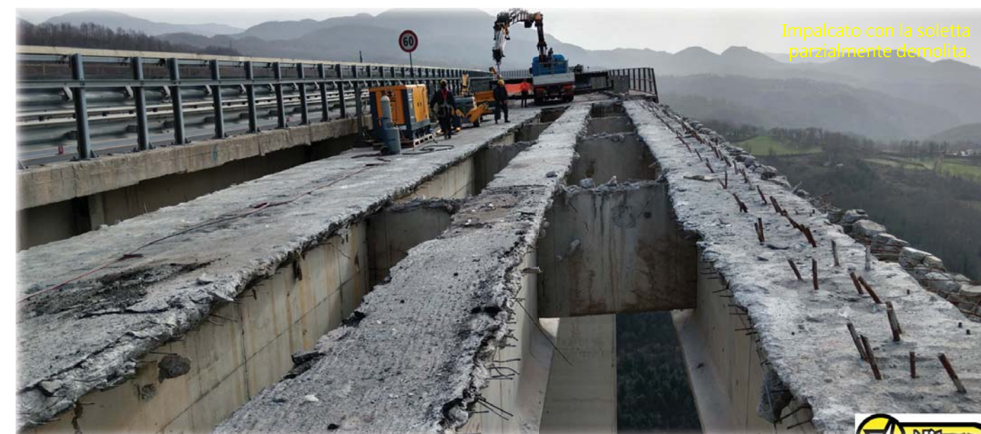
Pinza idraulica su escavatore elettrico radiocomandato, con pezzo speciale per la demolizione, "in negativo" sino a 4 metri, dei traversi precompressi di collegamento.
