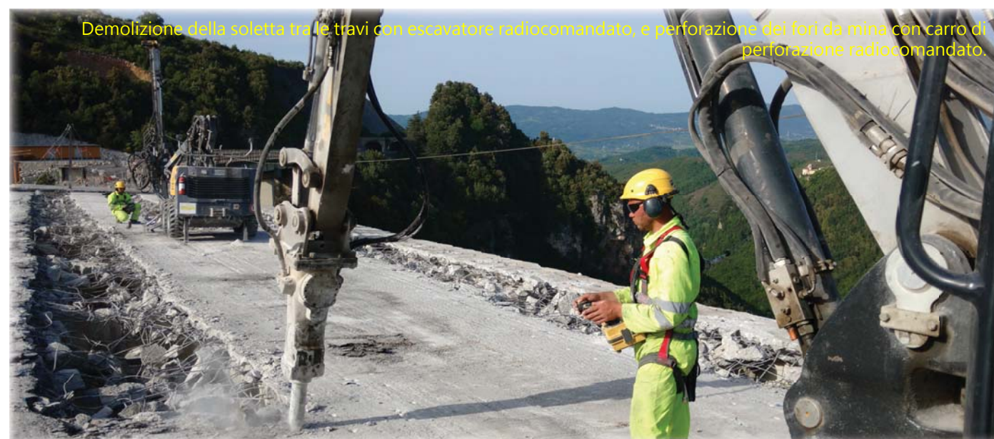
Demolizione soletta e cordolo e perforazione dei fori da mina.
