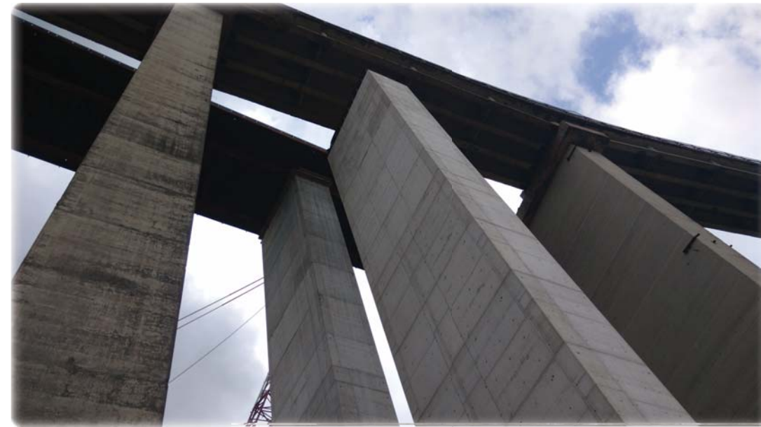
La nuova pila sotto il vecchio impalcato da abbattere, prima ...
