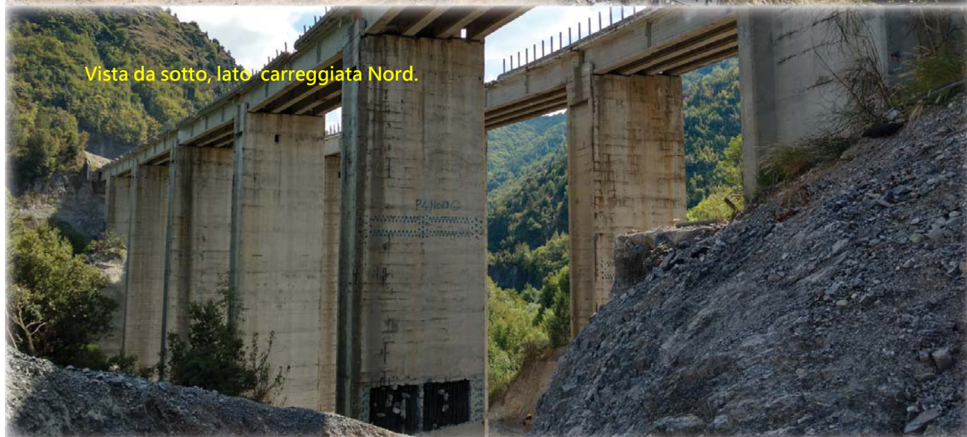
Vista da sopra, lato carreggiata Nord.
