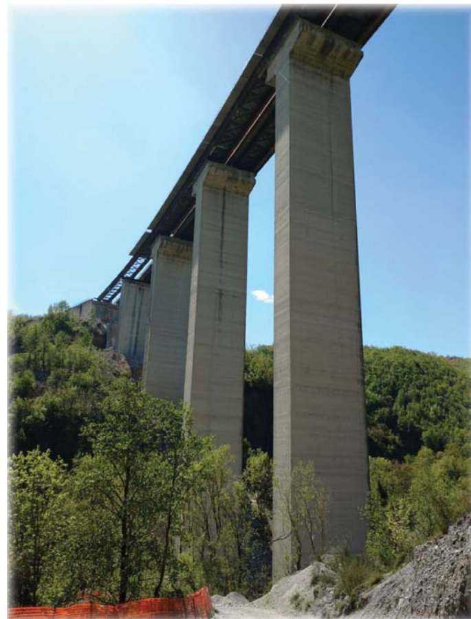
Nuova sovrastruttura del viadotto Jannello con la vecchia parzialmente demolita.
