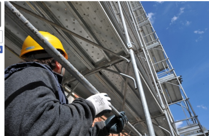
Un cantiere edile (archivio)
