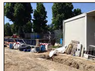
Cantiere Tramvia Firenze (FI)
